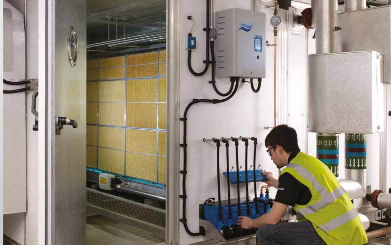
Condair ME med eksternt monteret hydraulikenhed
